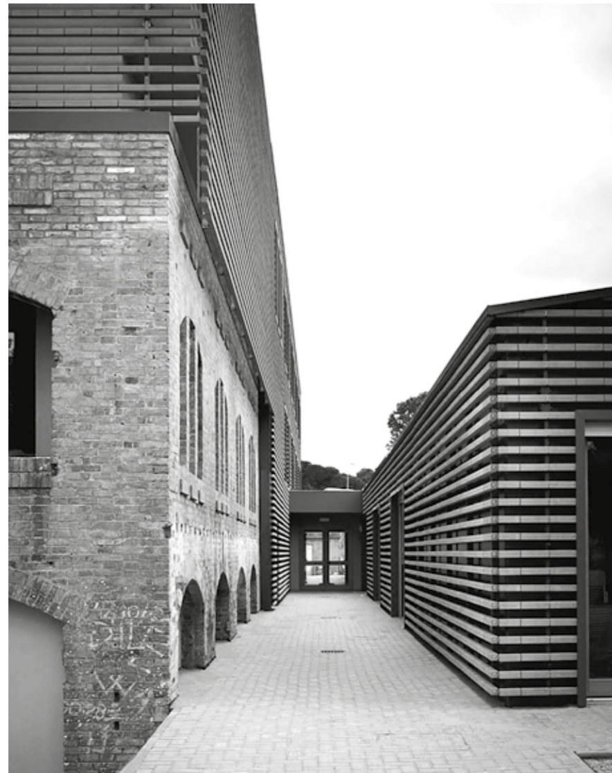
07. Recupero dell'ex-Fornace di Riccione di Pietro Carlo Pellegrini Architetti | Renovation of the former Kiln in Riccione by Pietro Carlo Pellegrini Architetti. Mario Ciampi
