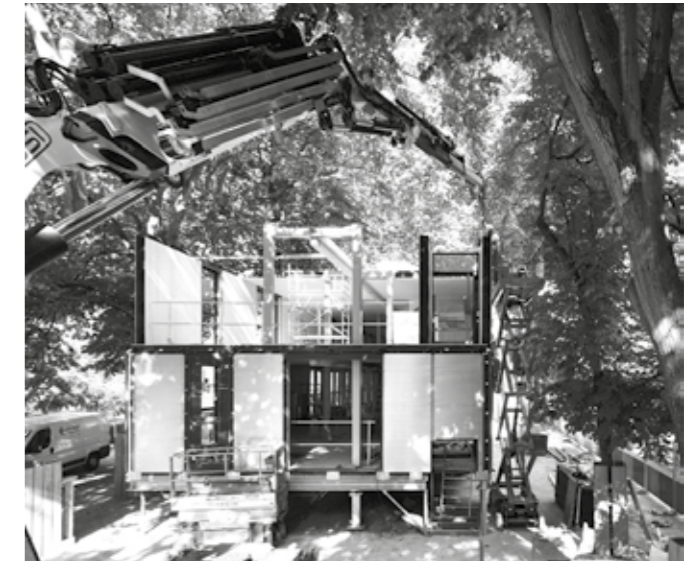
07. Realizzazione in cantiere della Wooden Nursery di Djuric Tardio Architectes a Parigi | On-site construction of the Wooden Nursery by Djuric Tardio Architectes in Parigi. Clément Guillaume
