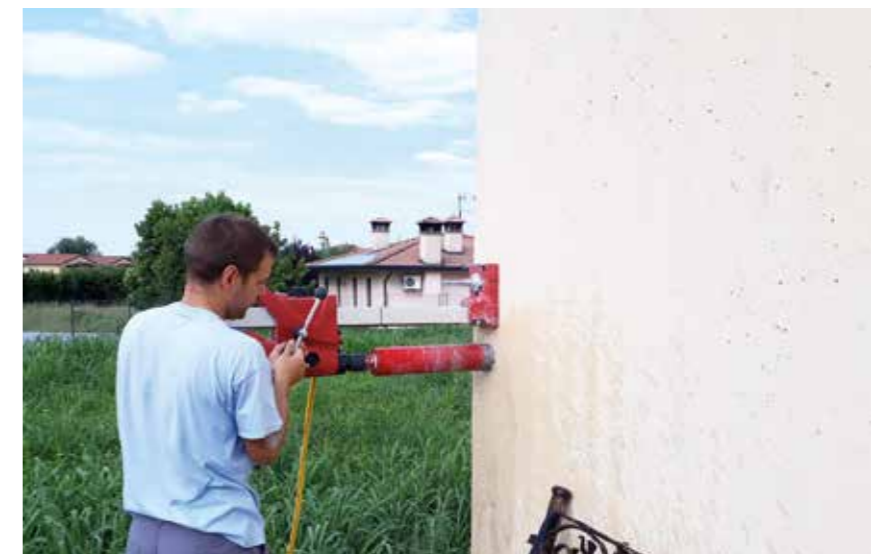
05. Prelievo di campioni sulle murature in calcestruzzo. 4 emme
