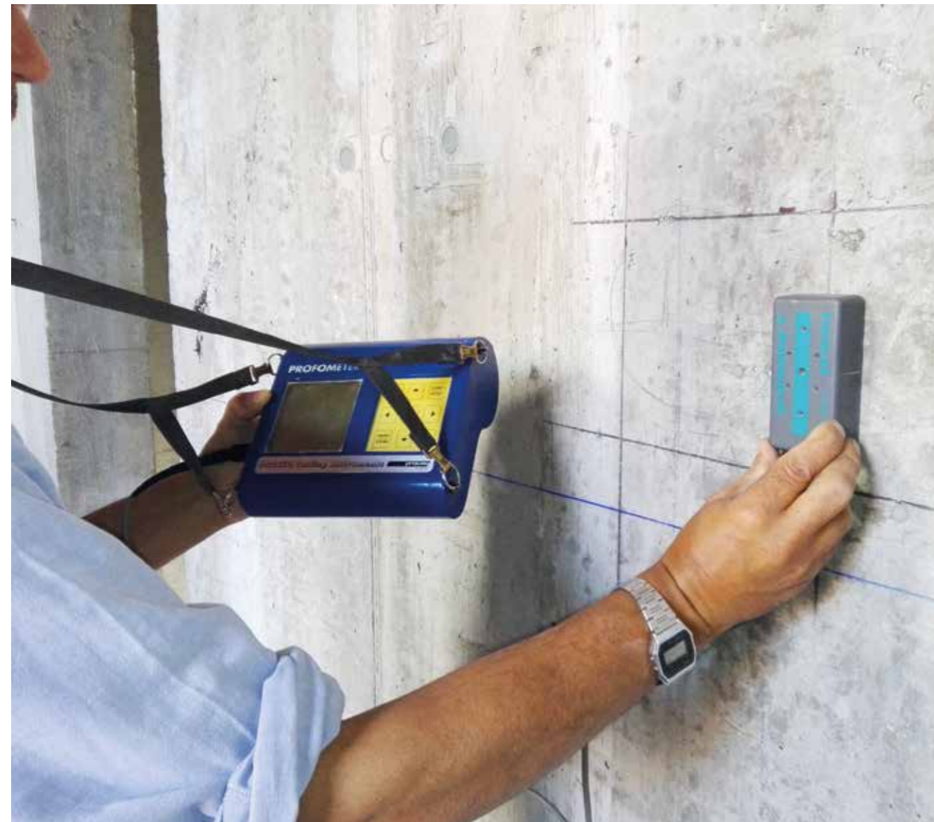
04. Indagini sulle murature in calcestruzzo. 4 emme
