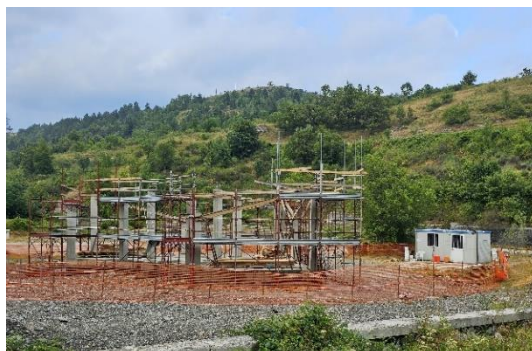
Figura 1. Un edificio in costruzione
