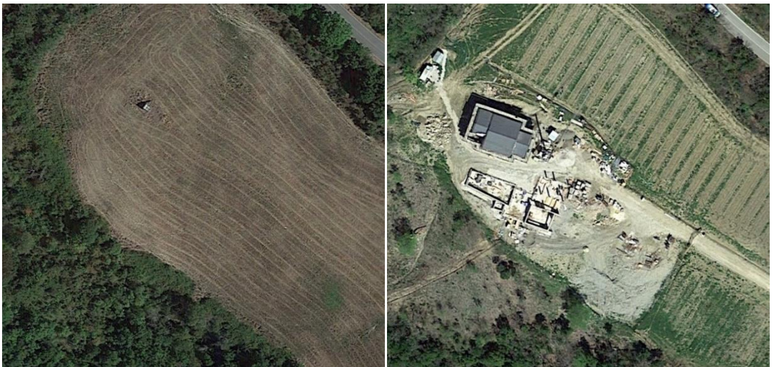
Figura 40. Consumo di suolo all'interno di un'area a pericolosità da frana (P3) nel comune di Casole d'Elsa in provincia di Siena (immagini 2019, a sinistra, e 2022, a destra)
