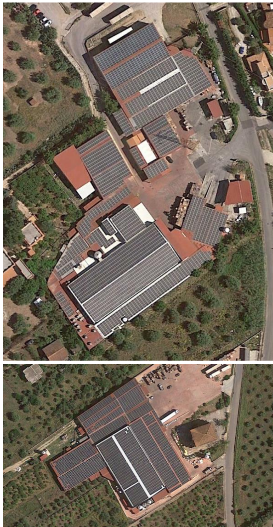
Figura 33. Esempi di tetti fotovoltaici (circa 1,2 ettari), comune di Altavilla Milicia (Palermo)
