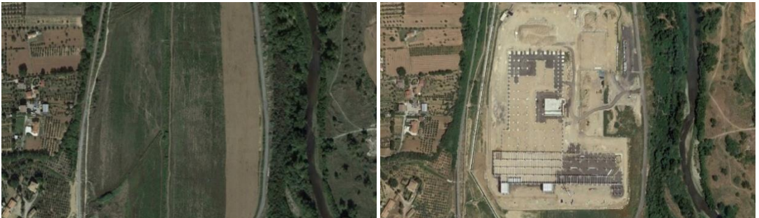
Figura 39. Consumo di suolo di circa 15 ettari per la realizzazione di un nuovo supermercato nel comune di Montalto Uffugo (Cosenza), realizzato in area a elevata pericolosità idraulica (immagini 2019, a sinistra, e 2022, a destra)
