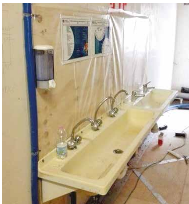
Approntamento lavelli all'interno del cantiere
