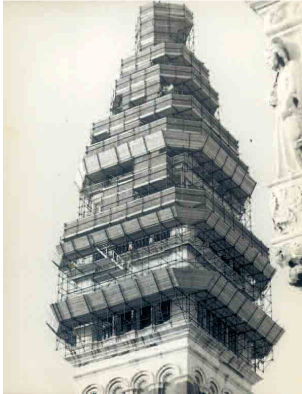
Impalcatura eretta durante il restauro del 1955
