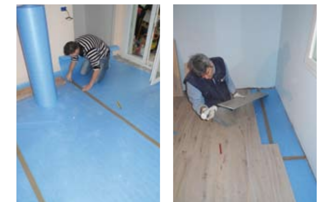
Figura 4 – Posa dello strato acustico anticalpestio e del pavimento flottante
