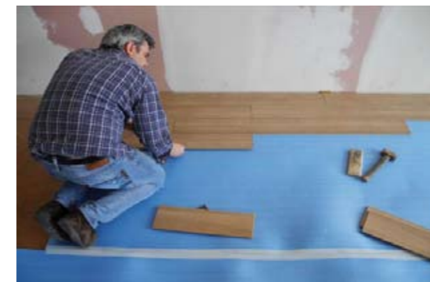
Figura 1 – Lo strato acustico resiliente ed il pavimento flottante posato a secco.
